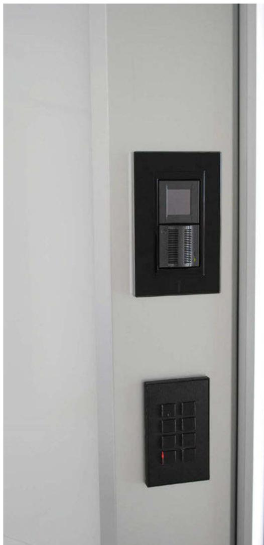
tra contatti magnetici e sensori volumetrici, più alcuni sensori biometrici per il controllo accessi. Il Milestone Systems può essere gestito localmente, per mezzo di tastiere a muro, touch screen e tablet, oppure da remoto mediante smartphone.
