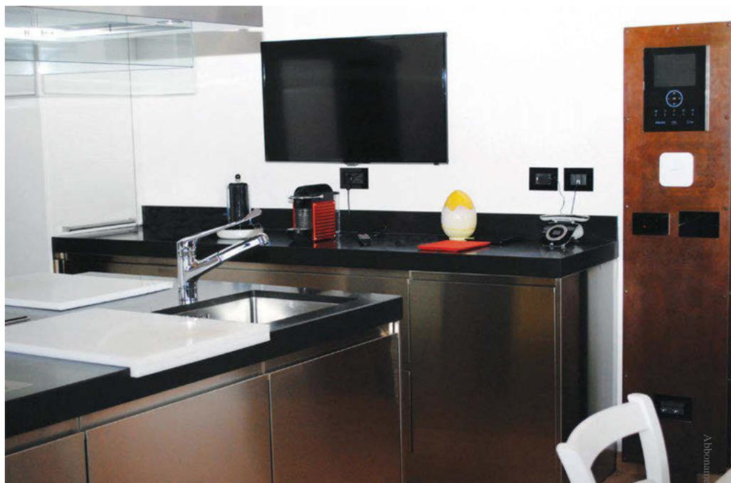
QUI SOPRA, LA CUCINA DELLA CASA PADRONALE: NELL'ANGOLO A DESTRA SI INTRAVEDE UNA DELLE STRUTTURE METALLICHE DISSEMINATE UN PO' IN TUTTA L'ABITAZIONE A FARE DA SUPPORTO A TOUCH SCREEN, TASTIERE DI CONTROLLO E IPAD; IN QUESTO CASO, LA STRUTTURA OSPITA UNA CRESLIGHT, UN TERMINALE VIDEOCITOFONICO BTICINO AXOLUTE NIGHTER, DUE PRESE DI RETE, UNA PULSANTIERA E UNA LAUNCHPORT, BASE DI RICARICA A INDUZIONE PER IPAD.
