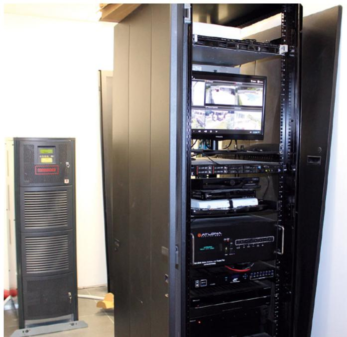
*Uno degli ambienti della sala tecnica, nel seminterrato. Il rack, a fianco del gruppo di continuità, contiene un monitor, una centralina RTI, le matrici audio video, i decoder, i server per TVCC e backup.*
